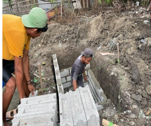
Gambar 2 Penyusunan material untuk pembuatan reaktor limbah aliran horisontal
