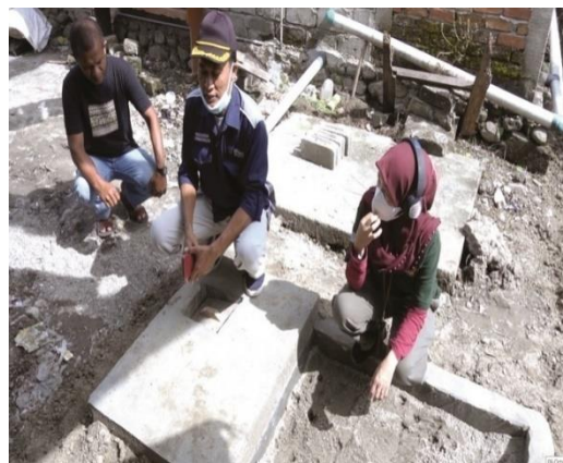
Gambar 6 Reaktor limbah Rumah tangga aliran horisontal menggunakan peran media pasir
