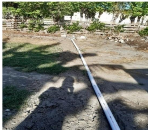
Gambar 4 Pipa penyaluran air limbah rumah Tangga ke dalam reaktor air limbah
