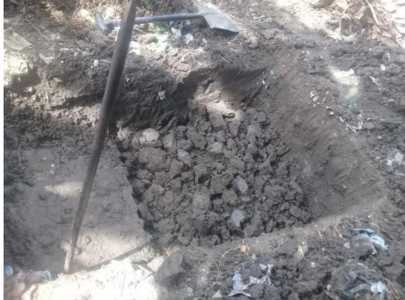
Gambar 1 penggalian tanah untuk pembuatan reaktor aliran air limbah Rumah Tangga
