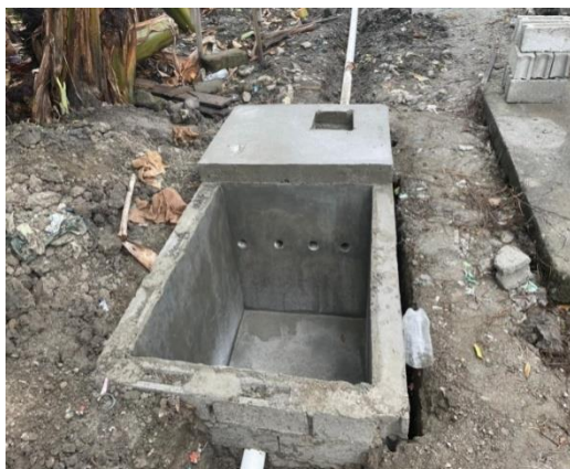
Gambar 5 Reaktor limbah rumah tangga aliran horisontal
