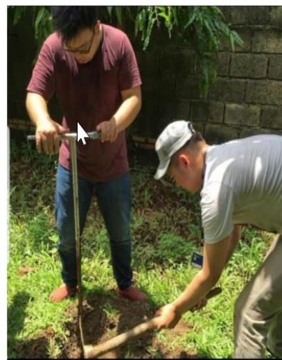
Gambar 4 Pembuatan lubang biopori
