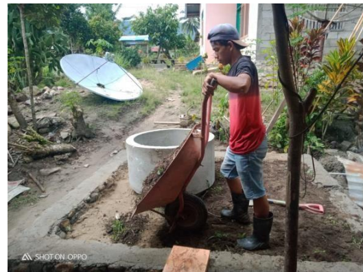
Gambar 2 Proses pembuatan sumur
